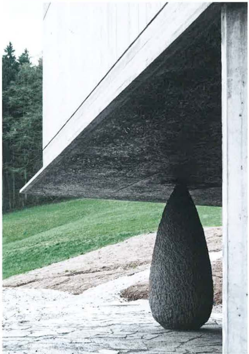
AUSKRAGENDE DECKE, AUF DEN „HINKELSTEIN“ GESTÜTZT | LA DALLE EN PORTE-À-FAUX SOUTENUE PAR LE « MENHIR »
